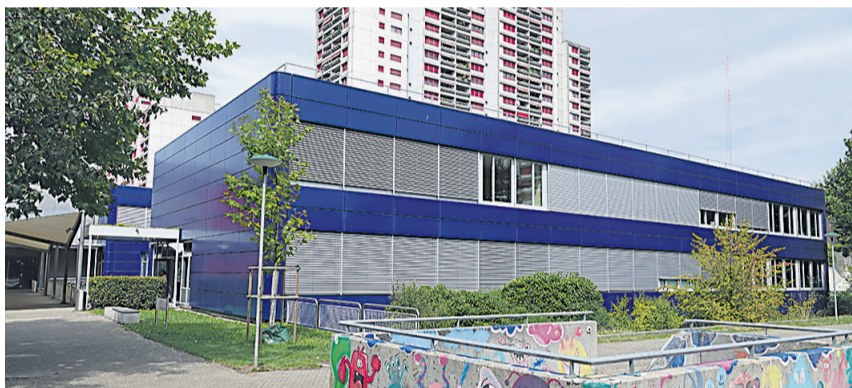
Die Schulanlage Liebrüti soll auch weiterhin mit Fernwärme beheizt werden.
